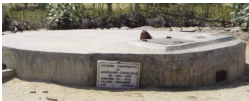
Une citerne pour conserver l'eau de pluie.
