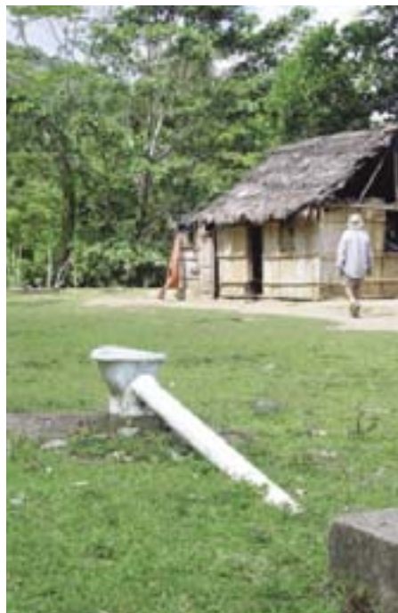
Una letrina sin terminar y abandonada en Honduras; como resultado de una planificación y un diseño no adecuados.
