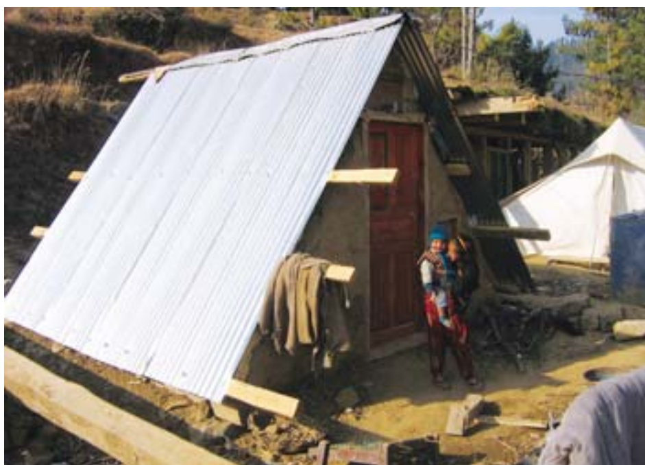
Vivienda temporal construida con materiales distribuidos por Tearfund en el distrito de Bagh.
