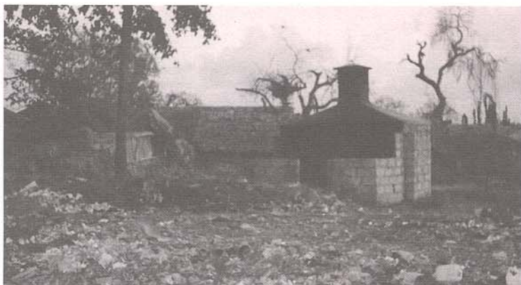
Cette cheminée sert à brûler les ordures dans un camp de réfugiés de Mombasa.
