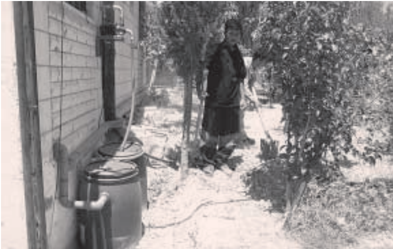
Le filtre d'eau grise d'INWRDAM en action.
