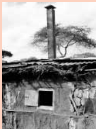
Maison massai traditionnelle mais avec une cheminée et une fenêtre pour réduire la fumée à l'intérieur.
