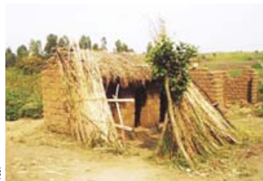
Latrines dans une école en République Démocratique du Congo.
